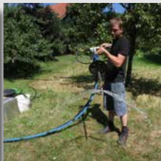
Flüssigkeit direkt injizierbar bis auf 70 cm Tiefe
