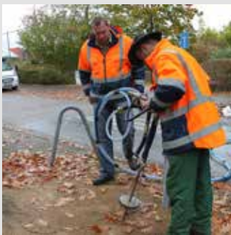
Injektion direkt an der Baumscheibe in einem Wohngebiet
