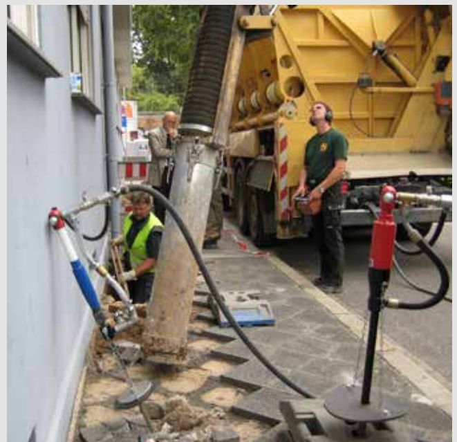
In Kombination mit dem Saugbagger in combination with a suction excavator
