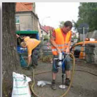
Injektion an der Baumscheibe am Naturdenkmal
